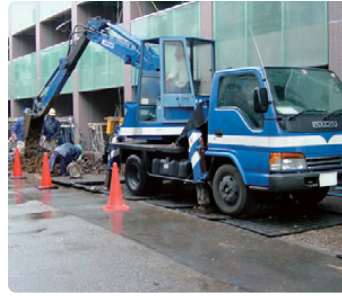
マンション外溝工事
